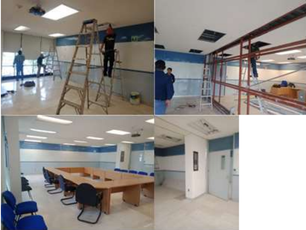
Fotografía 10. Ampliación del aula magna
