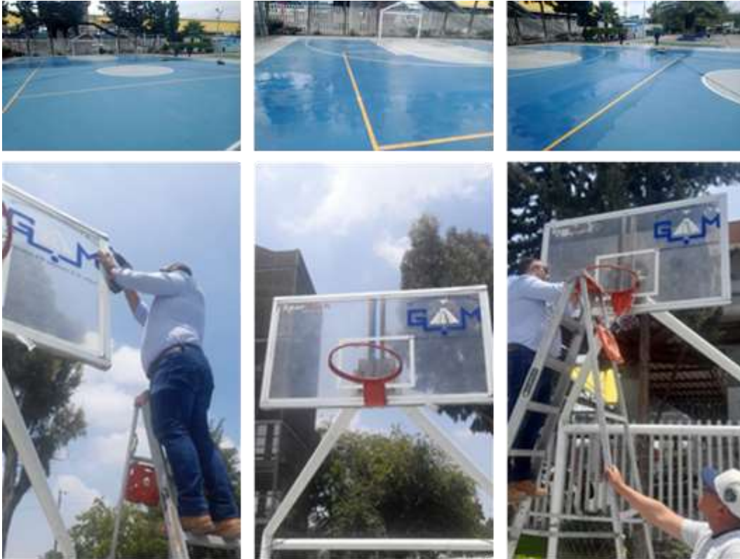
Fotografía 14. Mantenimiento a la cancha de usos múltiples.
